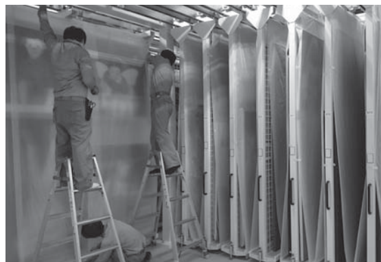
図10. 粉塵対策としての養生作業
