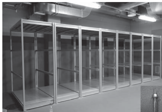
図4. 設置後の仮収蔵棚（右下図は床固定金具）
