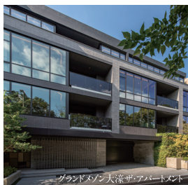
グランドメゾン大濠公園アパートメント
